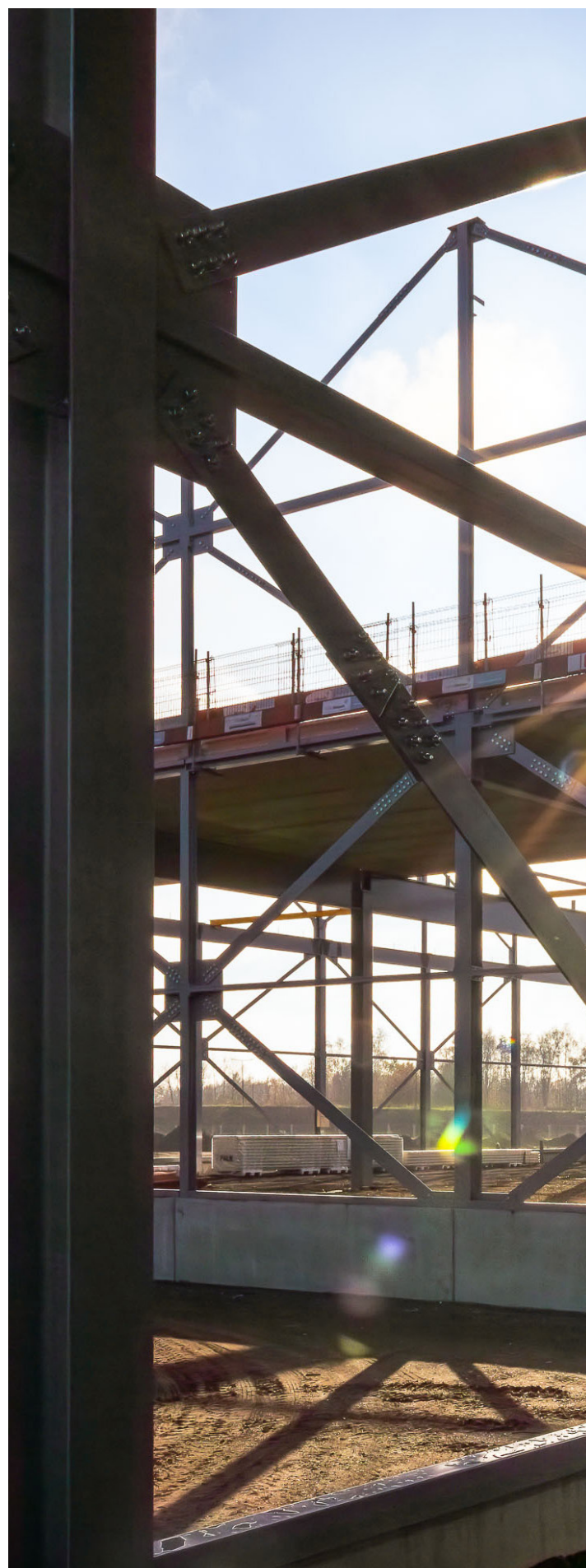
Boven: Er wordt 2,3 miljoen kilogram staal verwerkt in de constructie.
