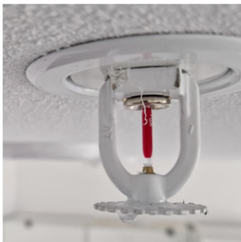
Afbeelding sprinklerkop.
